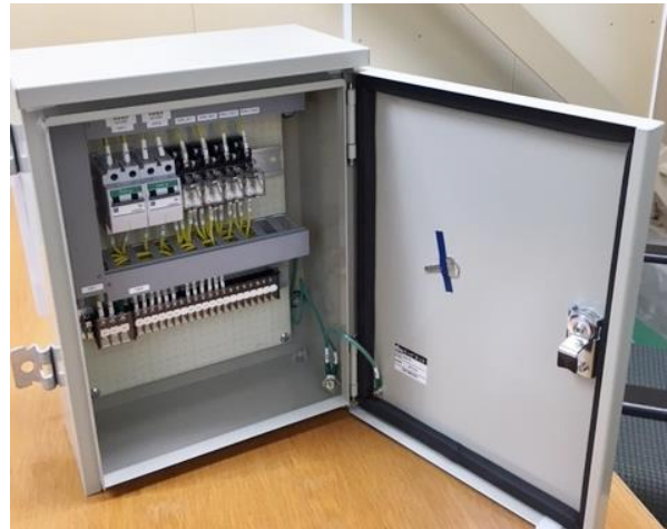
配電ボックス
